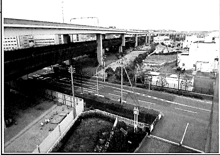
新磯子町交差点(海側付近)の現状。橋桁の架設を完了し、高欄工事を行っています
